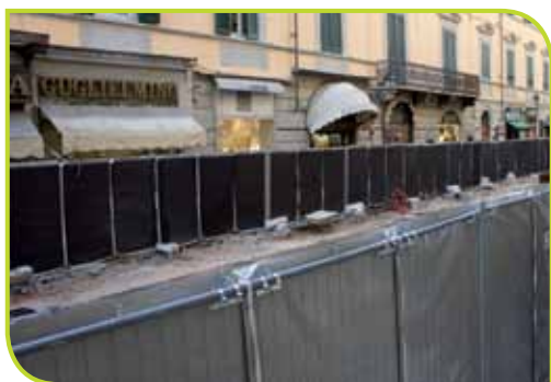
Barriera antirumore per cantiere cittadino (Pisa - Corso Italia)
