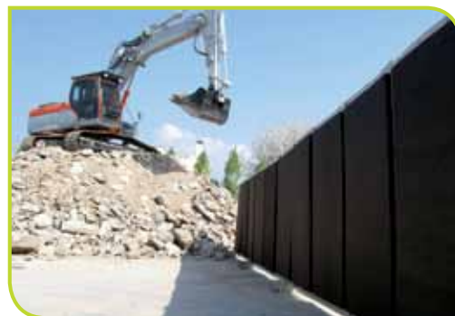
Barriera antirumore per cantiere / scavo
